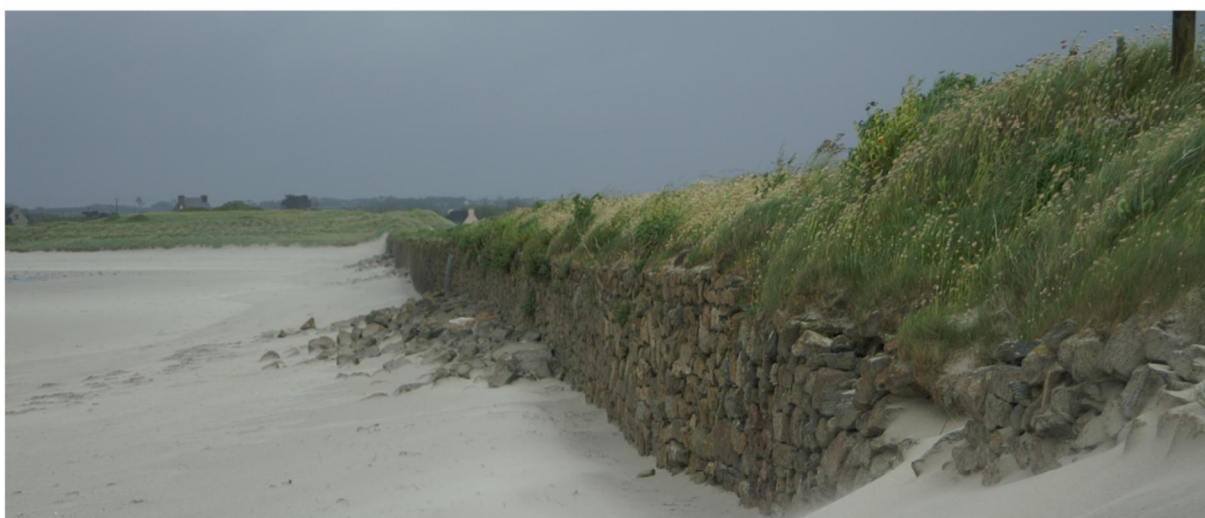
b) An Dig Nevez - La digue actuelle du polder du Curnic (parement amont)
