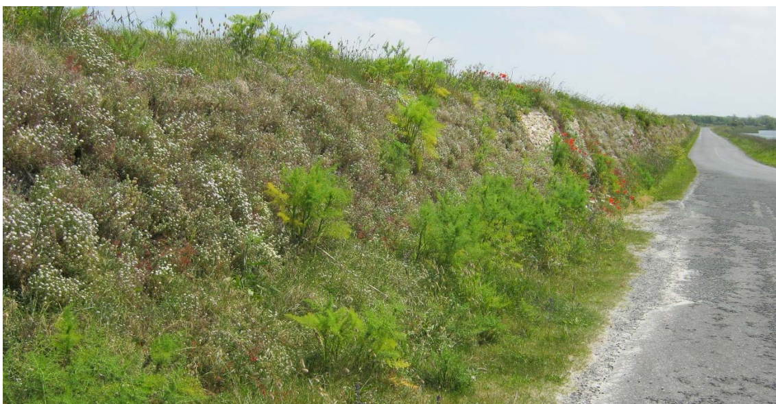
Figure 10 : Vue générale du parement côté terre depuis la rue des Pêcheurs
