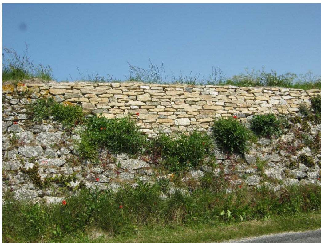
Figure 26 : Section 23 : Vue générale du parement repris en pierres sèches entre le pK 0,220 et le pK 0,230
