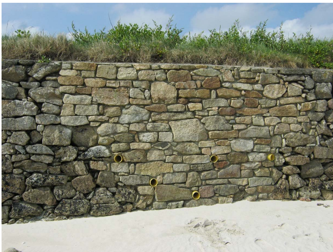
Figure 21 : Section 15 : Reprise entière du parement côté mer en moellons scellés au mortier
