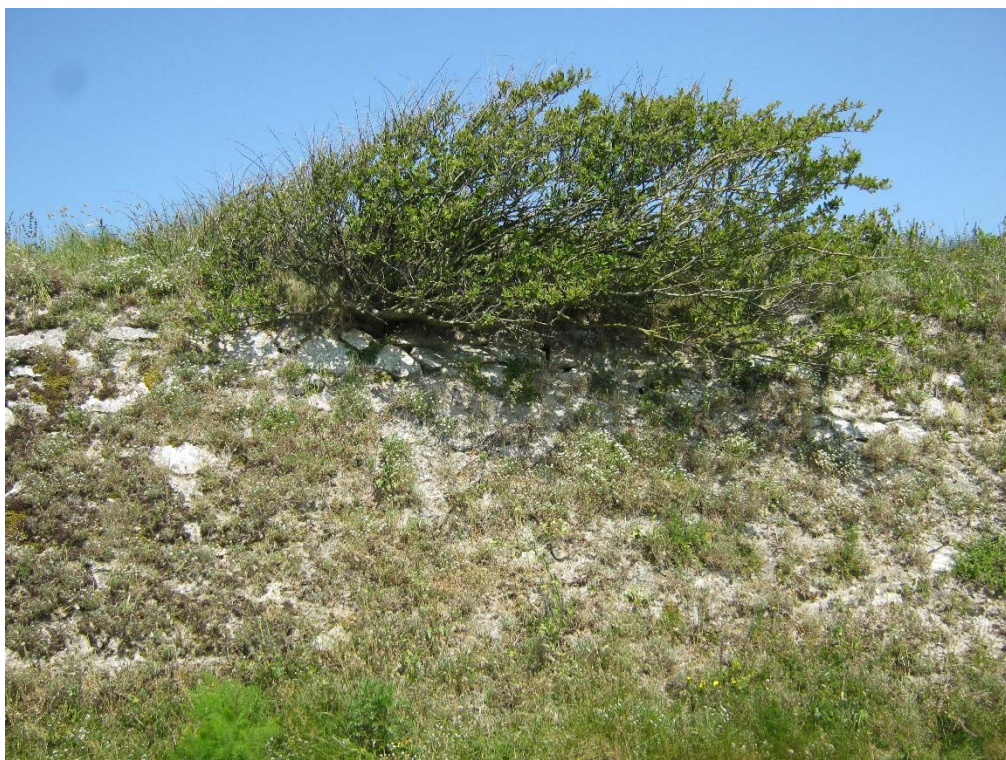
Figure 28 : Section 51 : Arbuste en tête de digue
