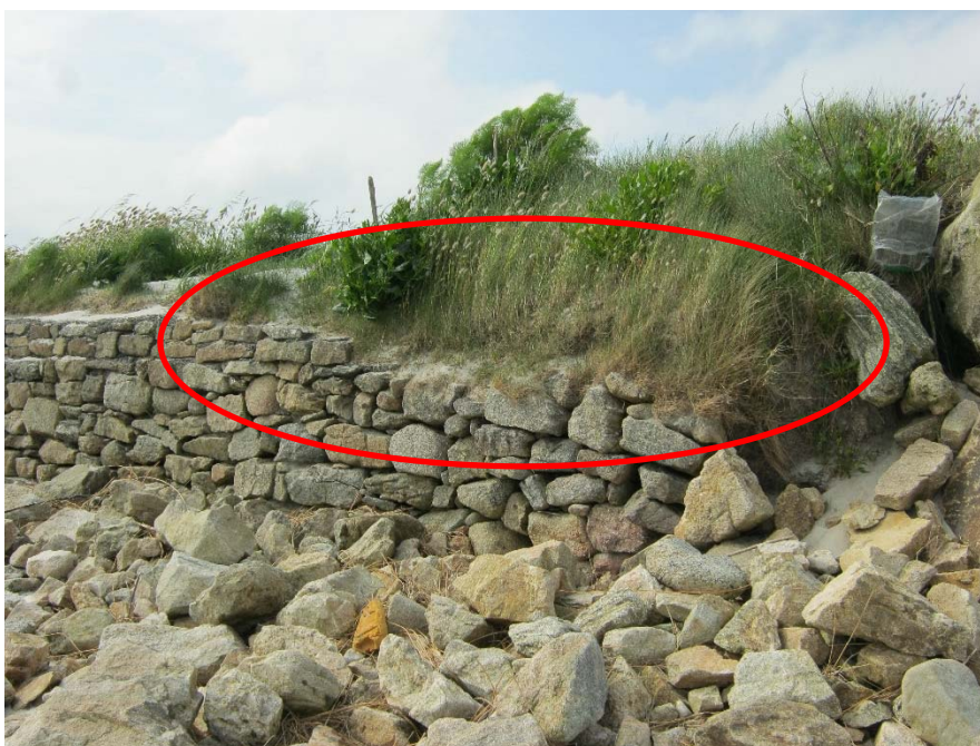
Figure 17 : Sections 1 à 3 : Effondrement de la partie supérieure de la digue
