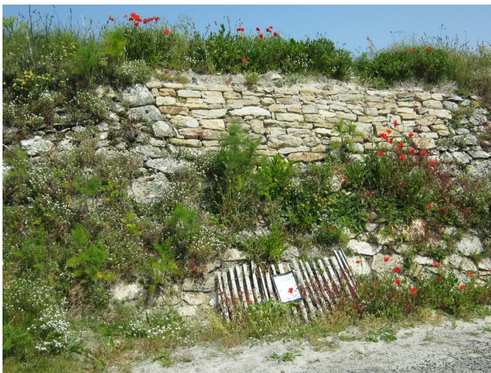
Figure 24 : Section 7 : Vue côté terre de la digue. Mur maçonné récemment repris.
