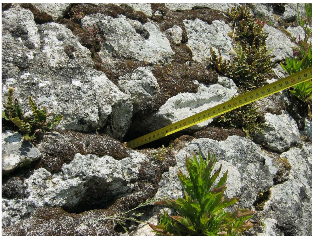
Figure 25 : Section 11 : Cavité dans la digue au pK 0,106
