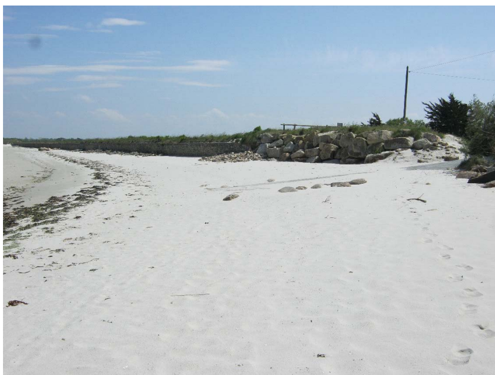
Figure 6 : Vue générale du parement côté mer depuis le côté de la rue des Pêcheurs
