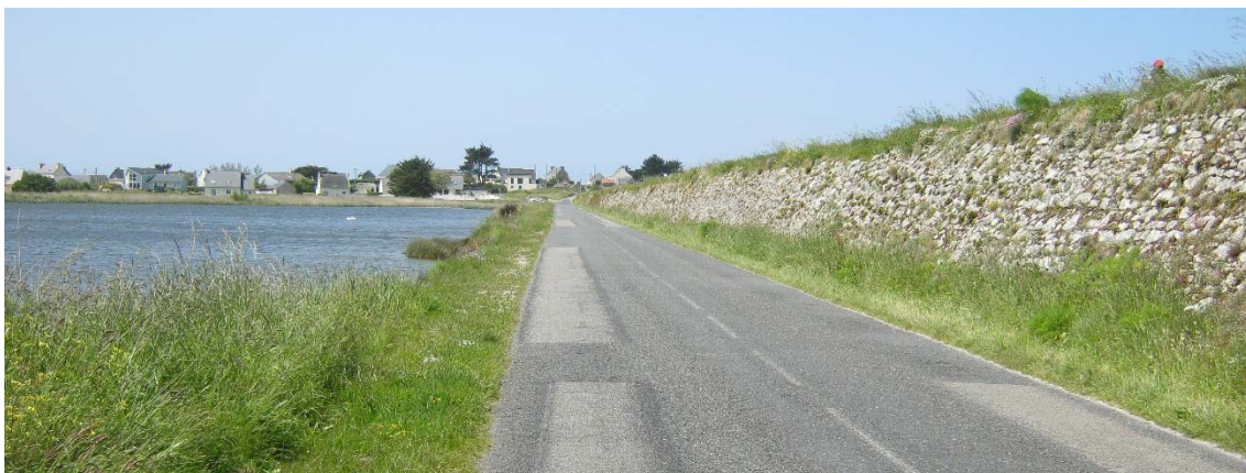
Figure 9 : Vue générale du parement côté terre depuis la route de Penn An Dig
