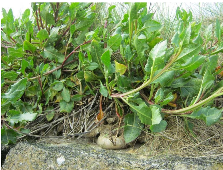
Figure 18 : Sections 3 à 10 : Végétation en partie supérieure du mur pK 0,08 à 0,09
