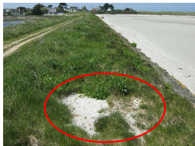
Figure 13 : Détail de zone de remblaiement récent sur la crête
