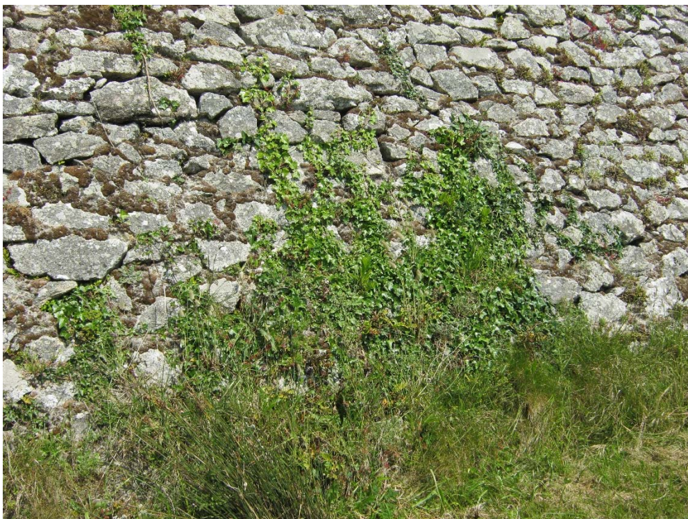
Figure 27 : Section 38 : Lierre terrestre envahissant du pK 0,371 au pK 0,374
