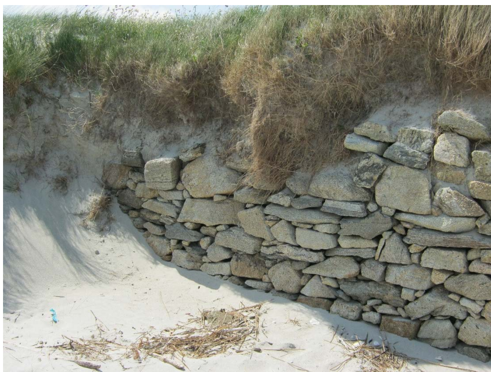
Figure 22 : Section 52 : Fin de la digue côté route de Penn An Dig
