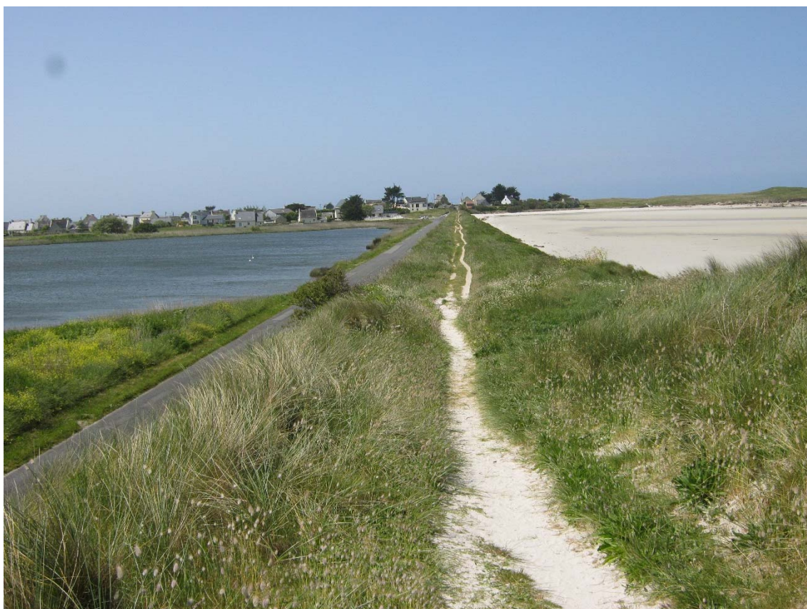
Figure 7 : Vue générale de la crête de la digue depuis la route de Penn An Dig
