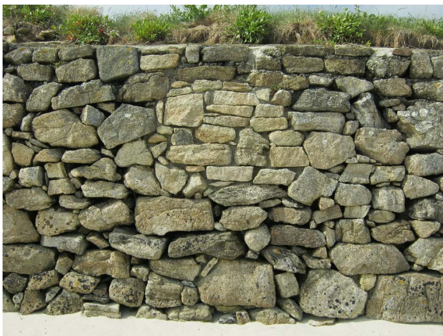
Figure 19 : Section 13 : Rejointement des pierres
