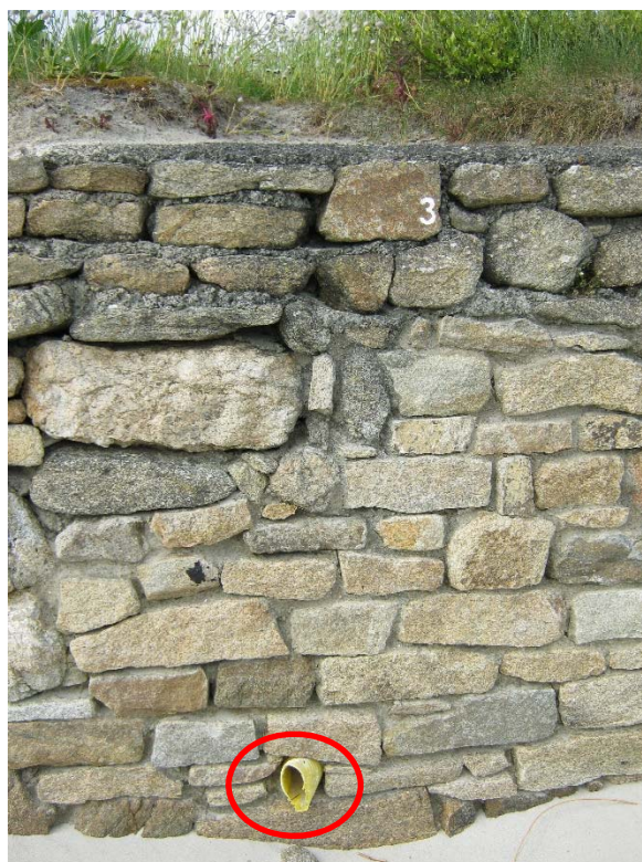
Figure 14 : Dispositif d'évacuation des eaux d'infiltration de la crête (barbacane) en parement côté mer
