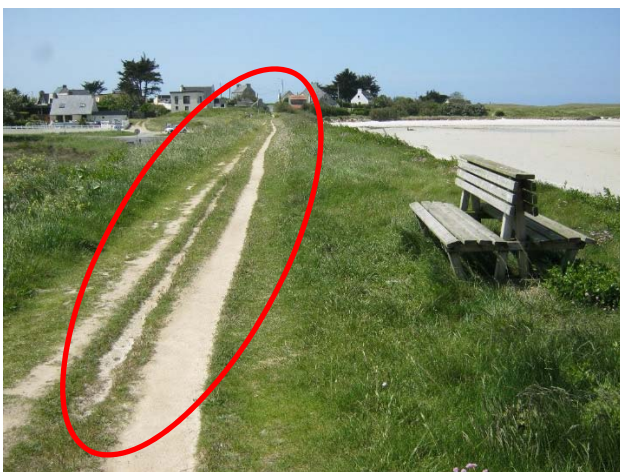
Figure 12 : Détail de l'érosion et du piétinement localisés au centre de la crête
