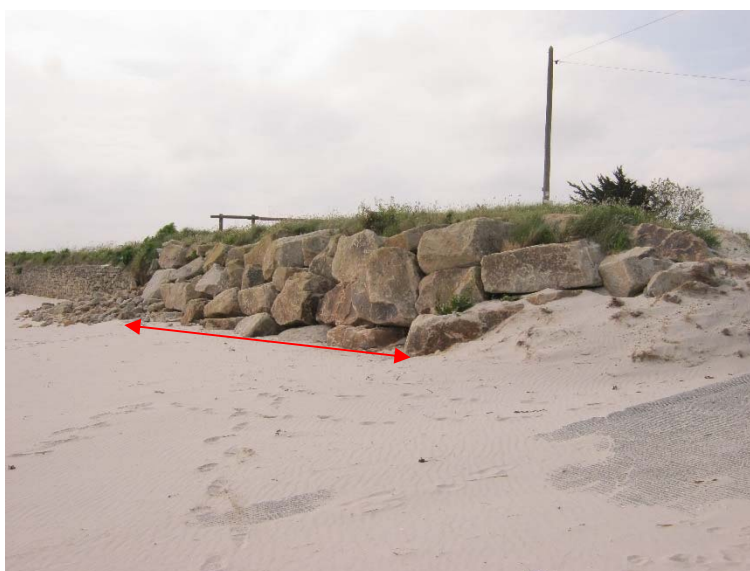
Figure 16 : pK 0,00 à 0,02 : Effondrement du mur moellons et protection mise en place par bloc rocheux
