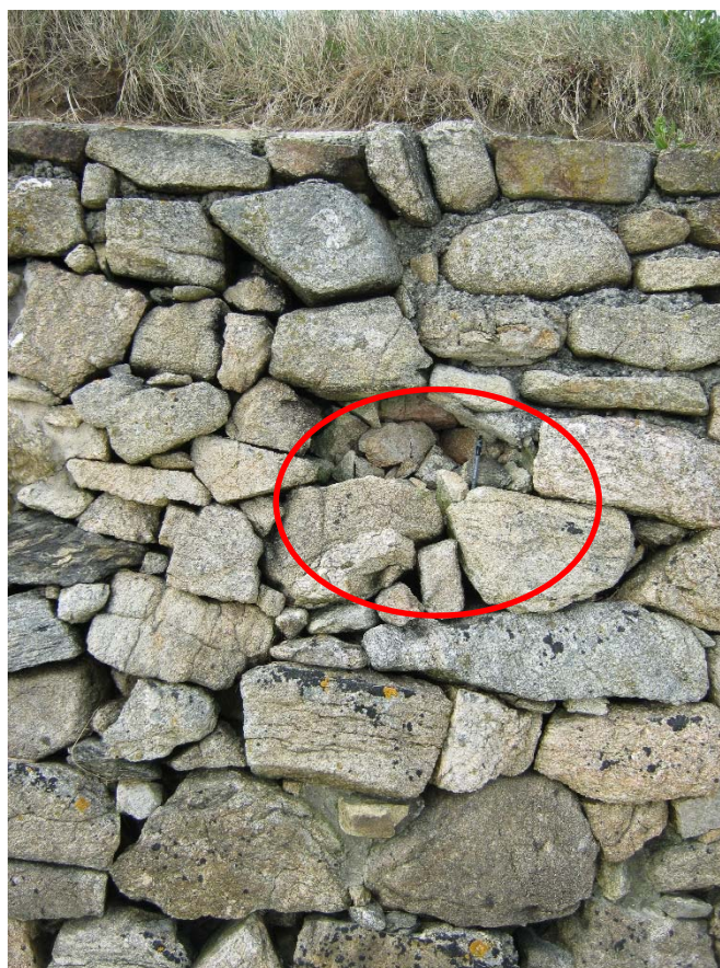
Figure 15 : Moellons manquants en parement côté mer entre le pK 0,13 et le 0,14
