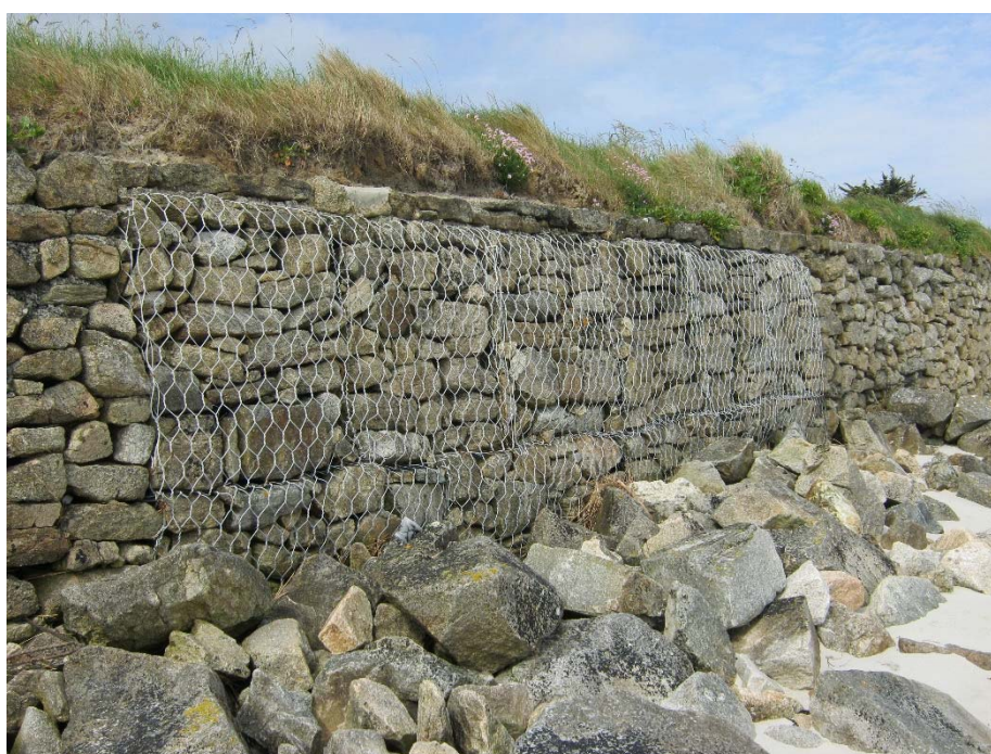
Figure 20 : Section 12 : Vue générale de la protection du parement côté mer par un grillage triple torsion
