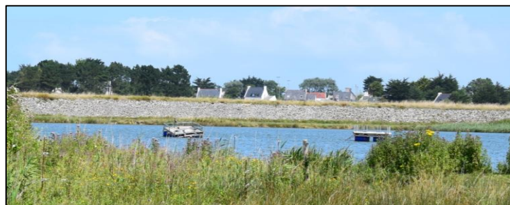
Figure 2 : Digue actuelle avec l'étang au premier plan (Source : M.Chevalier)
