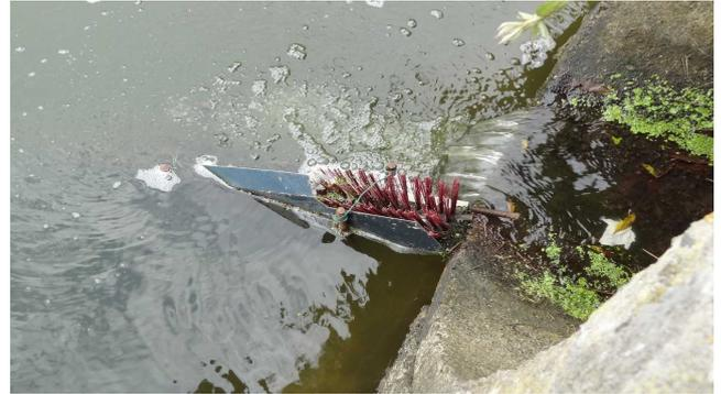
Figure 8. Passe à anguille installée en 2014 au niveau d'une buse au Cleger par le SMEBL
