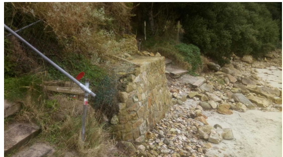
Figure 6. Avancement du mur mur maçonné au bout du chemin de Tresseni (en haut 2017 et en bas à l'issue de l'été 2018)
