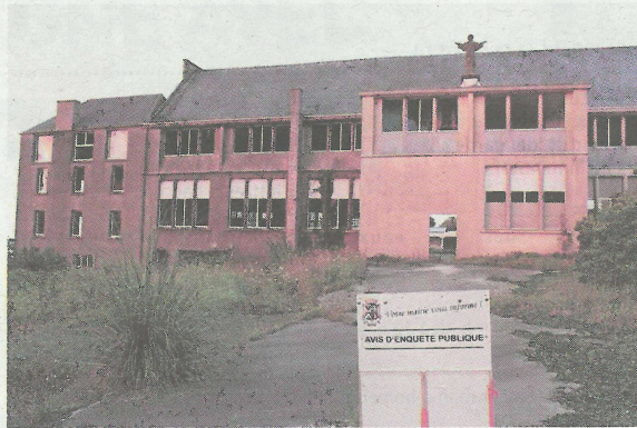
Accessible sans difficultés, insalubre et dangereux, le site de l'ancienne école du Sacré-Coeur, Skol-an-Aod, est en état d'abandon manifeste.
