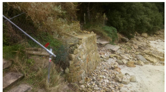
Figure 6. Avancement du mur maçonné au bout du chemin de Tresseni (en haut 2017 et en bas à l'issue de l'été 2018)
