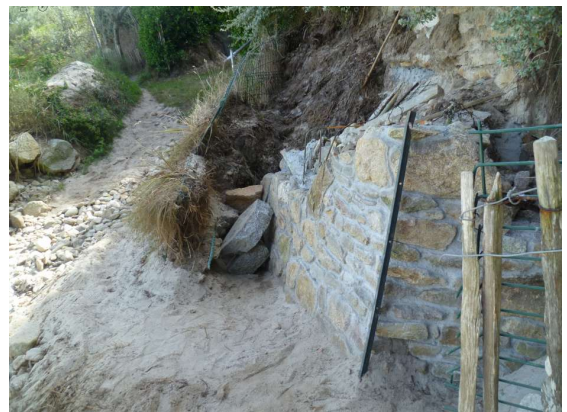
Figure 6. Construction en cours d'un mur maçonné au bout du chemin de Tresseni
