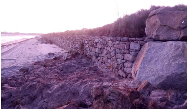
**Figure 2 : Vue du mur refait avant réalisation arase**
