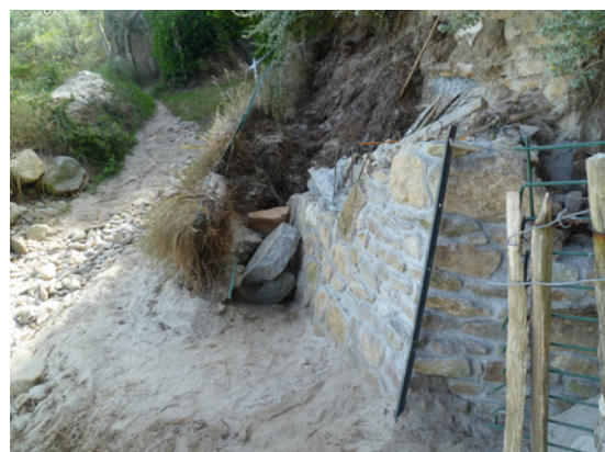
Figure 18. Construction en cours d'un mur maçonné au bout du chemin de Tresseni
