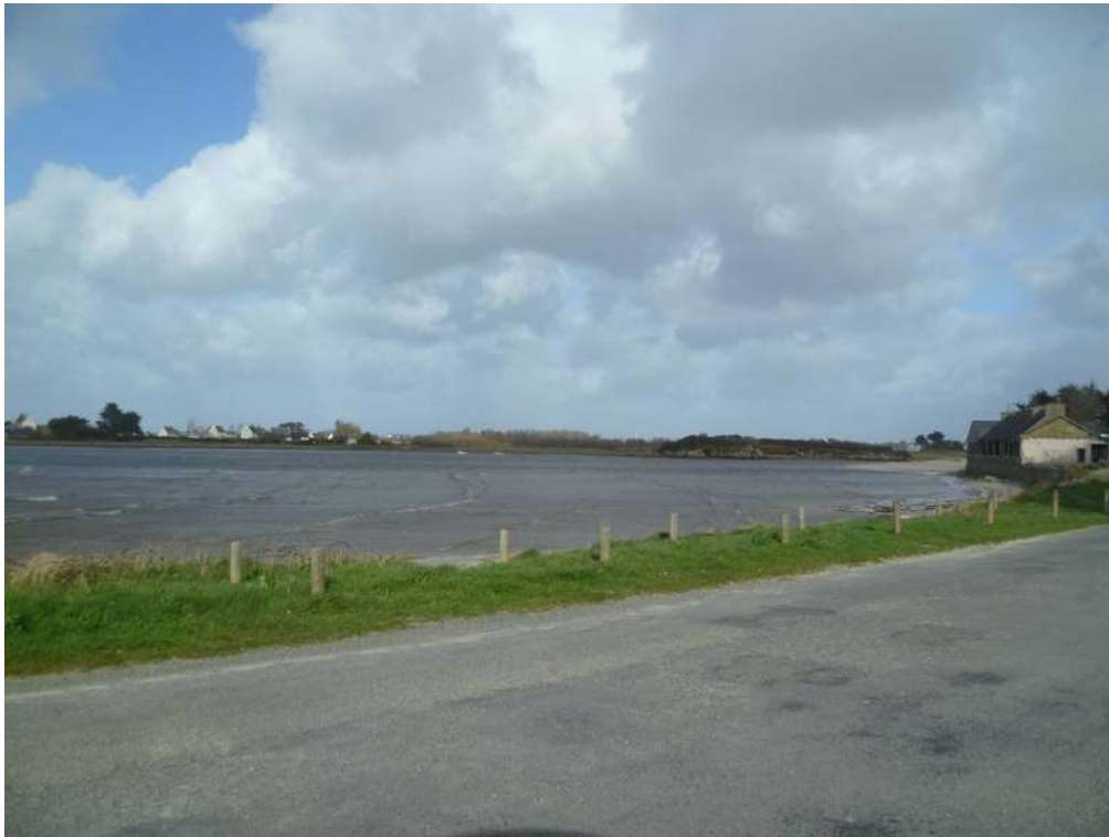
Aod Ar Groaz. Réparation d'alignements de plots (pose de nouveaux plots)
