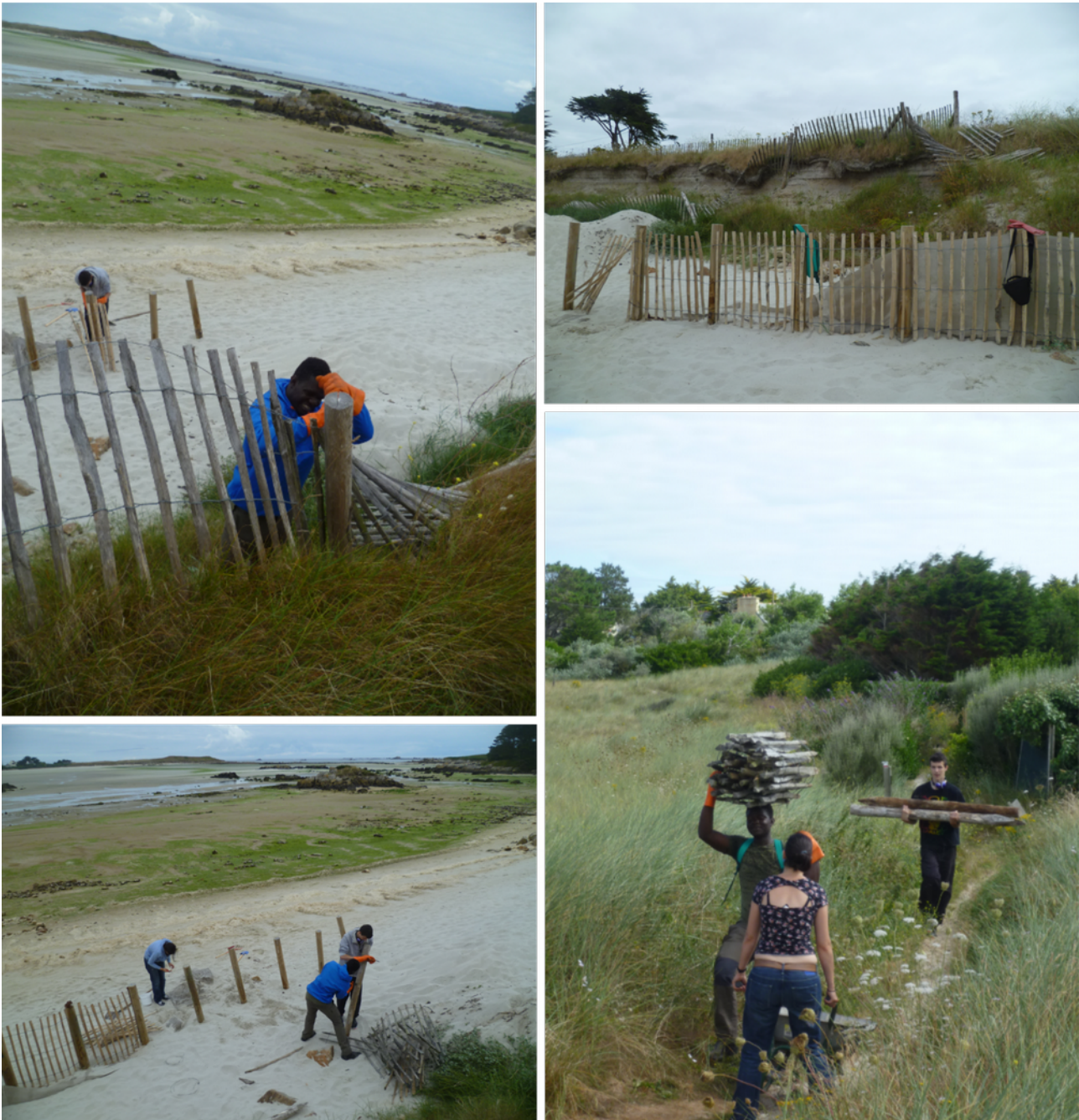
Figure 33. Suppression de ganivelles et géotextile à An Ode Wenn
