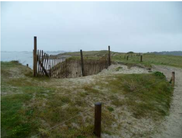
Entre pointe du Skeiz et Curnic. Pose de barrières d'ensablement et clôture monofil.
