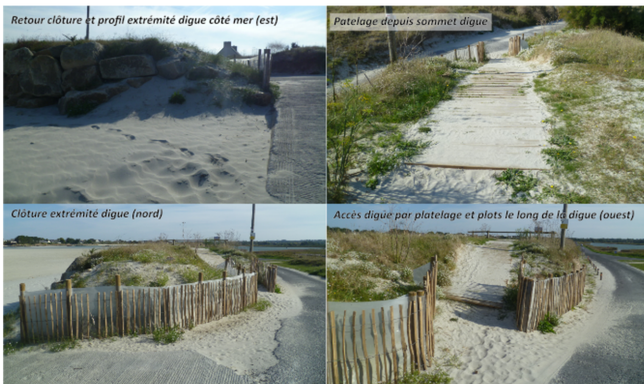
Figure 19. Aménagement de l'accès à la digue du polder, rue des pêcheurs
