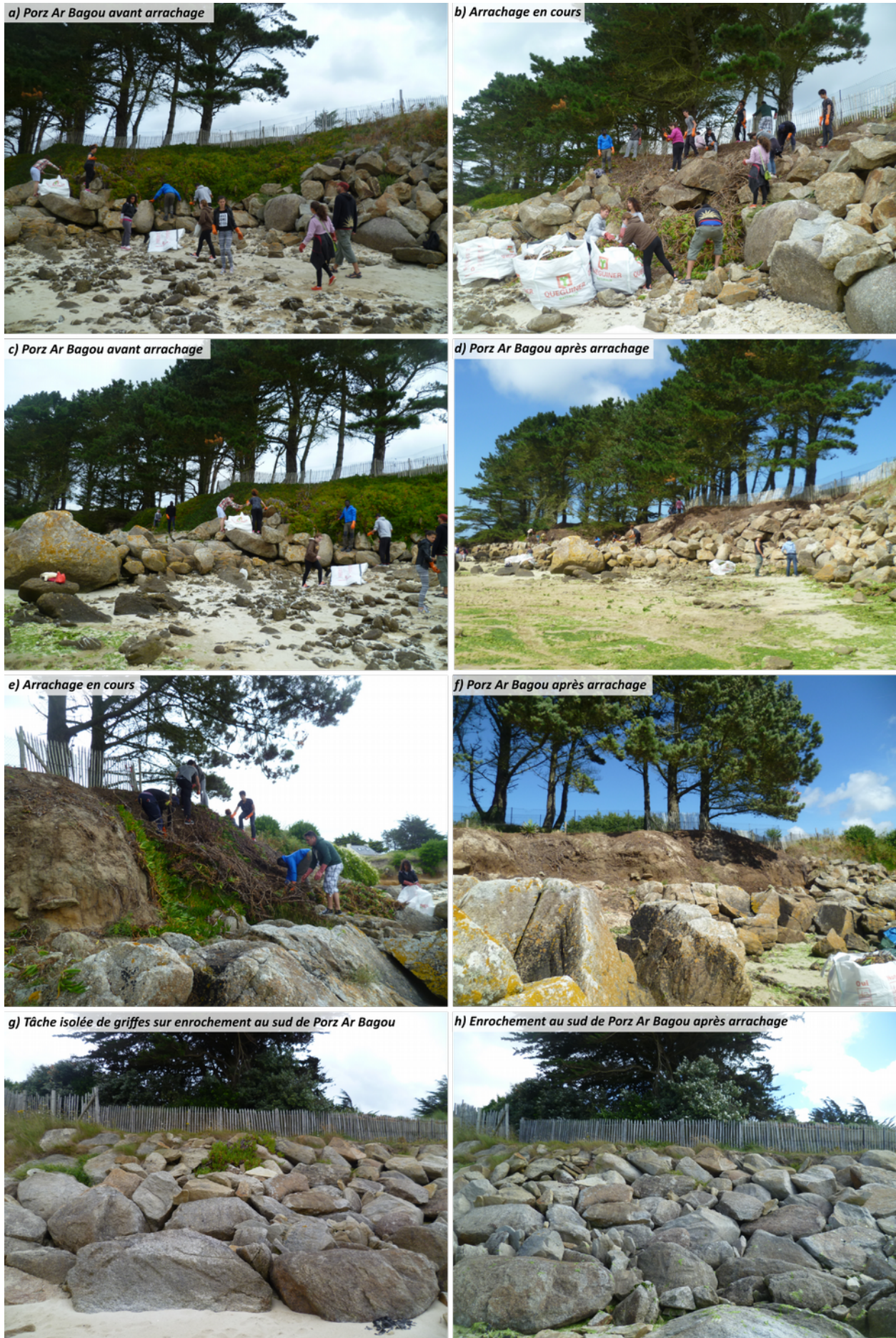
Figure 38. Le chantier d'arrachage de griffes de sorcières en images : aperçus avant/après
