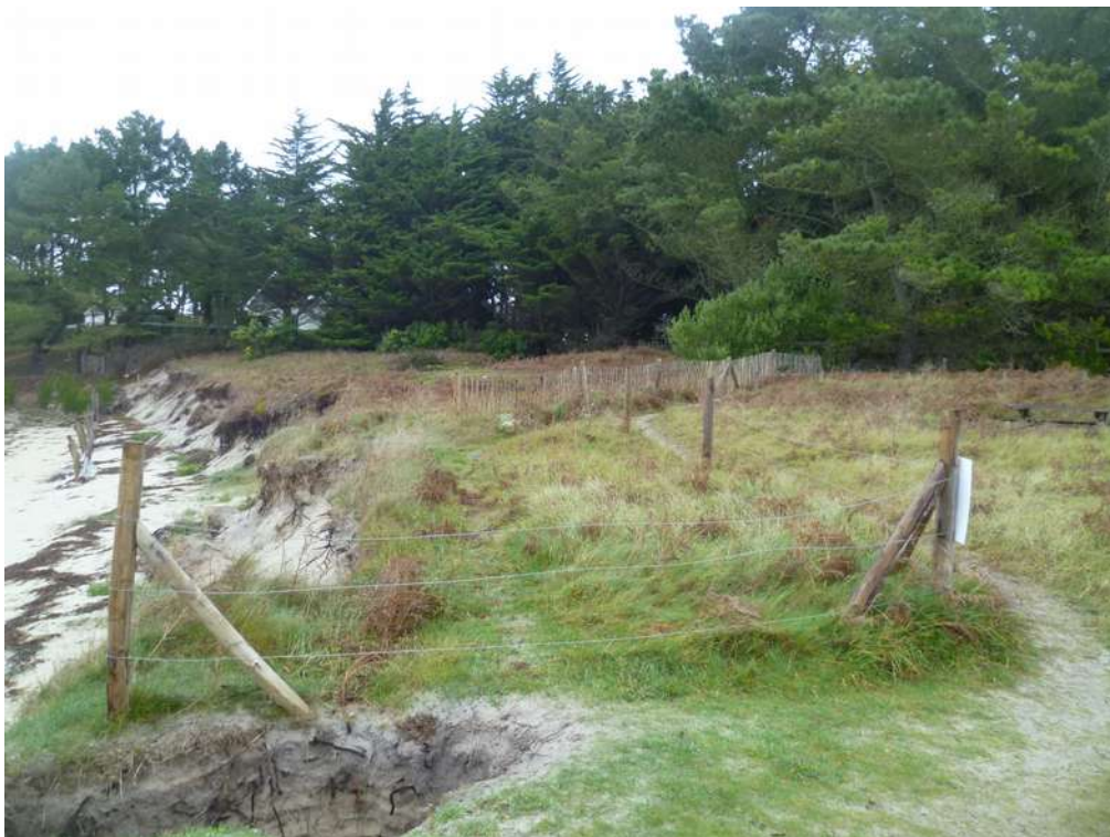
Porz Olier. Poste clôture trifil pour délimitation nouveau tracé GR34.
