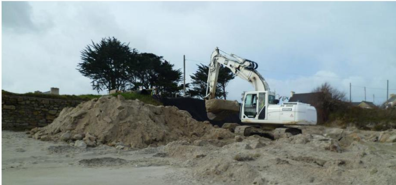
Le tas de sable et pierres à gauche est issu de la suppression de l'ancien muret.
