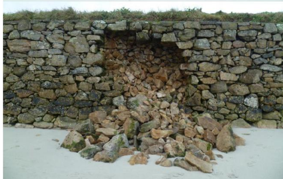
Figure 6. Effondrement entre 154 et 156 mètres environ dans la nuit du 02 au 03 janvier. Vue avant (05/11/2013) et après (03/01/2014). Code anomalie : ParMer_150-160_20140103_a_eff.
