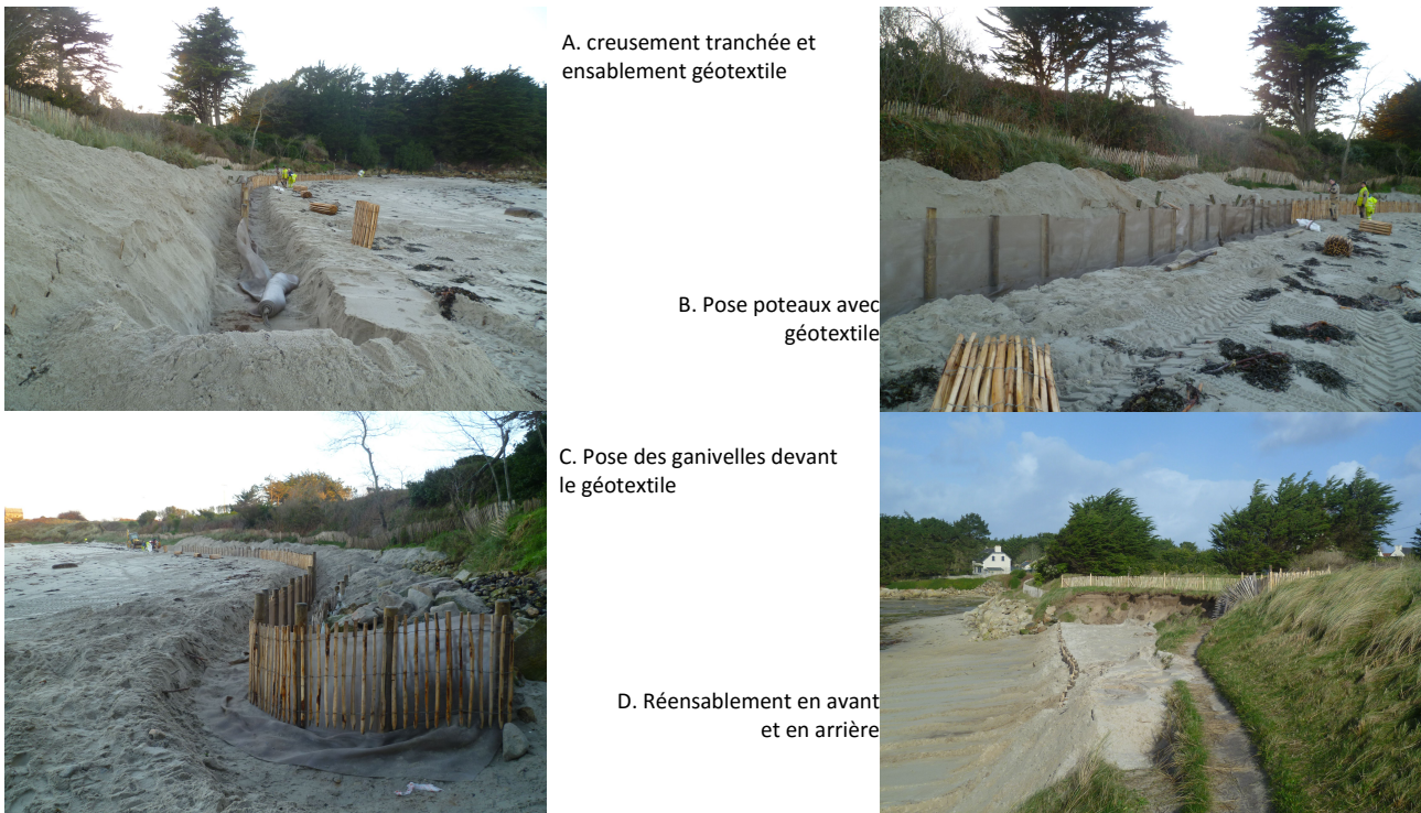
Figure 4. Étapes pose barrières d'ensablement (A, B, C : Aod An Ti Hard ; D : An Ode Wenn)
