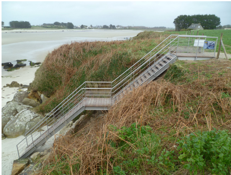
Figure 5. Escalier avec pallier intermédiaire aux grands Barrachou.
