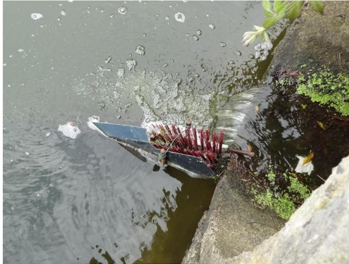
**Figure 7. Aménagement pour faciliter le franchissement par les anguilles de l'Alanan au lieu-dit Le Cleguer**
