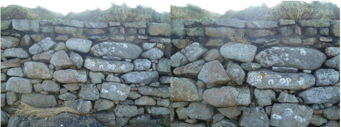
Figure 8. Réparation immédiate dès inventaire, d'une petite anomalie par calage d'un bloc
