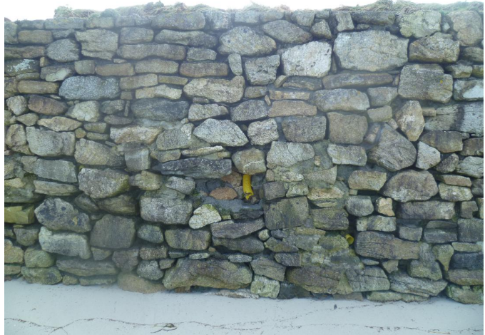
Figure 7. Blocs manquants contigus au tronçon ParMer_220-230
