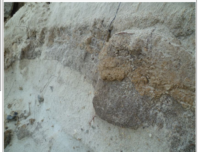
Figure 11. Détail de la bande de terre glaiseuse entre deux couches de sable et correspondant probablement au sommet de la digue à sa réalisation.
