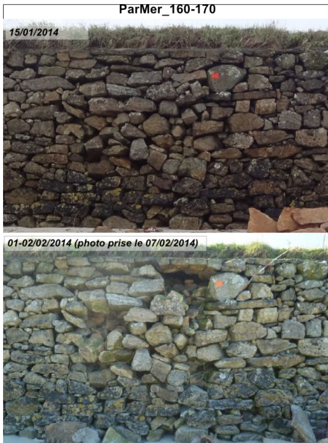
Figure 13. Effondrement, départs et glissements de blocs au niveau du tronçon ParMer_160-170
