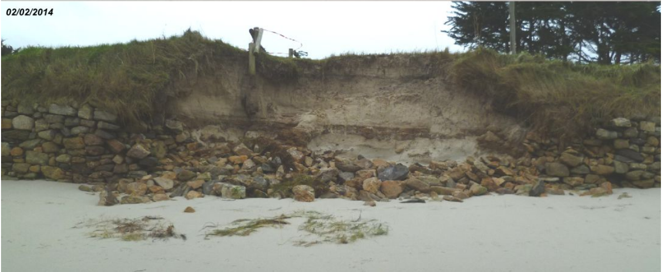
Figure 8. Effondrement entre 15 et 22 mètres environ dans la nuit du 01 au 02 février. Vue avant (05/11/2013) et après (07/02/2014). Code anomalie : ParMer_010-020_20140202_a_eff.
