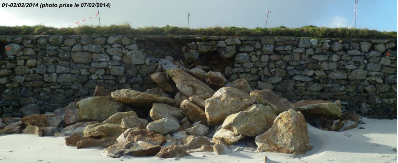
Figure 12. Elargissement suite à l'événement du principal dommage enregistré début janvier malgré la sécurisation par un enrochement.
