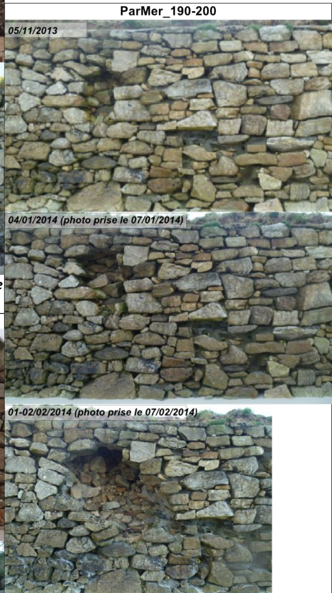
Figure 14. Agrandissement du trou au tronçon ParMer_190-200 suite à effondrement.
