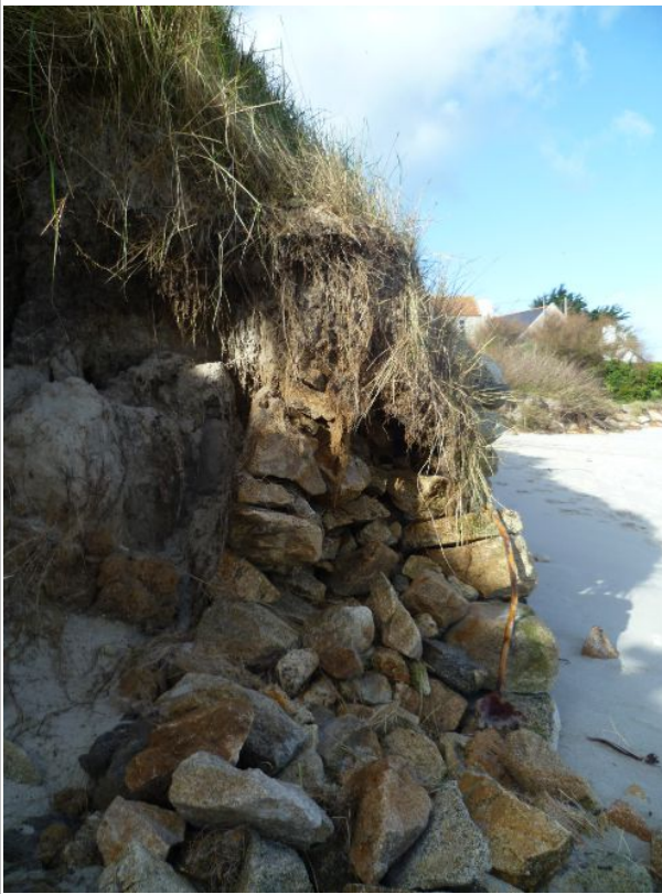
Figure 9. Vue en coupe du mur en limite d'effondrement
