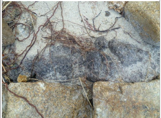
Figure 10. Couche noire (tourbe ?) accolée au mur à l'intérieur du corps de digue
