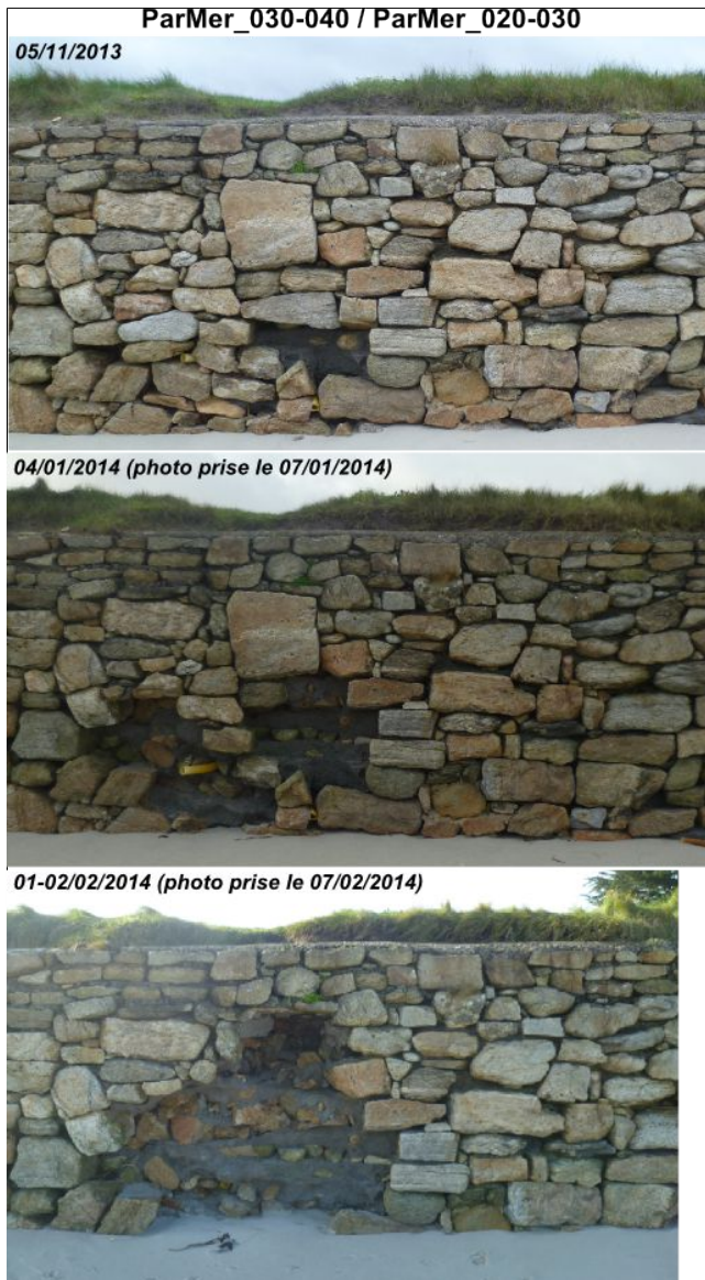
Figure 16. Agrandissement de deux trous en un seul à la limite des tronçons ParMer_020-030 et ParMer_030-040
