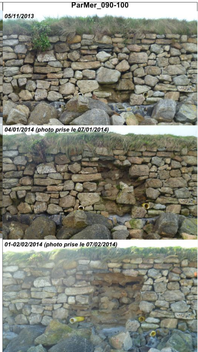
Figure 17. Agrandissement du trou au tronçon ParMer_090-100
