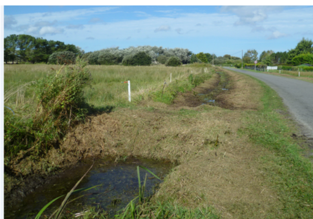
Illustration 1: Exemple de franchissement d'entrée de champ à modifier (en hiver 2013, après forte pluie) à Illustration 2: Même franchissement en été 2016 (stagnation même avec faible débit).
